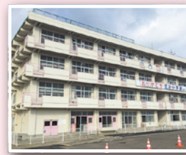
▲ 旧荒井小学校校舎
